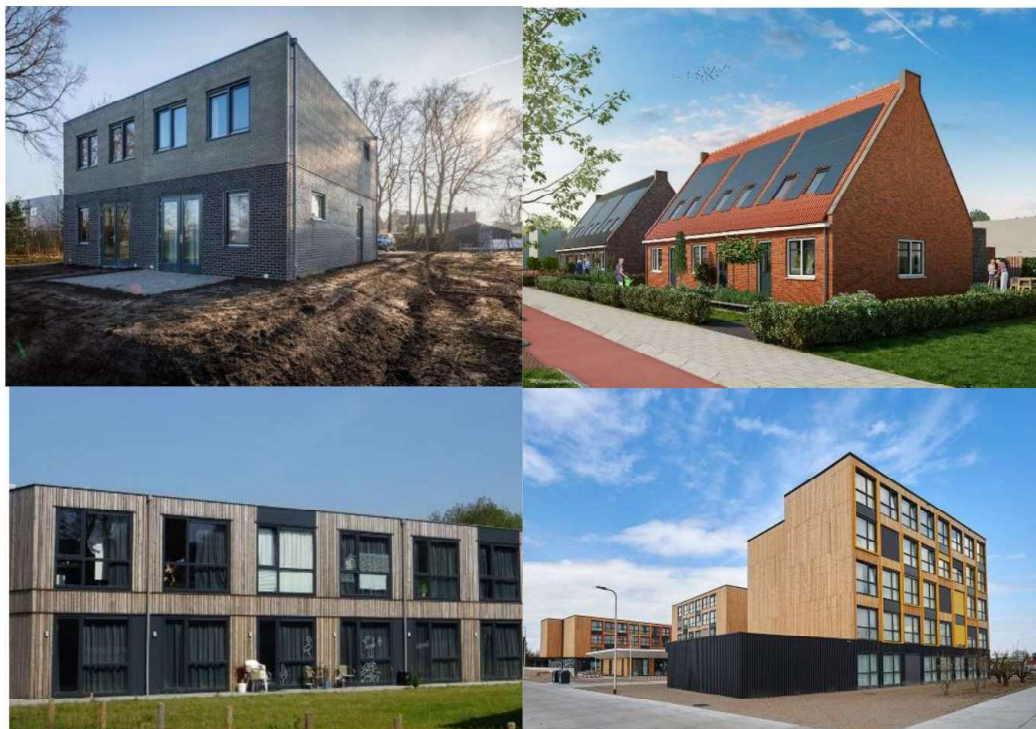
FIGUUR 1: DEMONTABELE BOUW: BLOQZ, OLBECON (LOCHEM); REMONTABELE BOUW FIJN WONEN – VAN WIJNEN; TIJDELIJKE WOONUNITS (DEN BOSCH); TIJDELIJKE HUISVESTING LARS (LELYSTAD)
