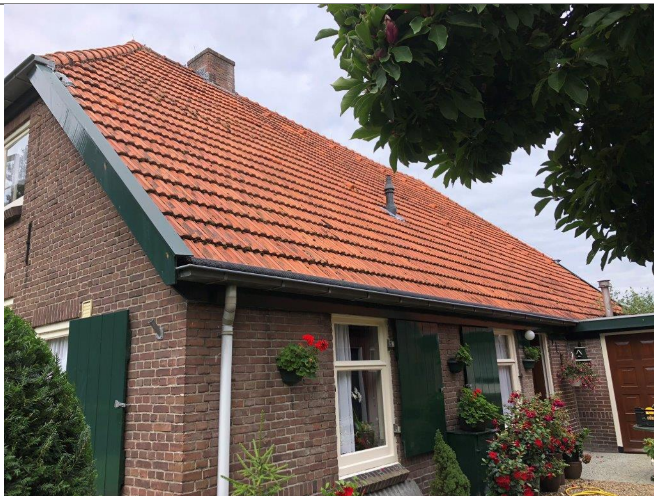
Voorgevel / rechter zijgevel – aansluiting windveer / goot
