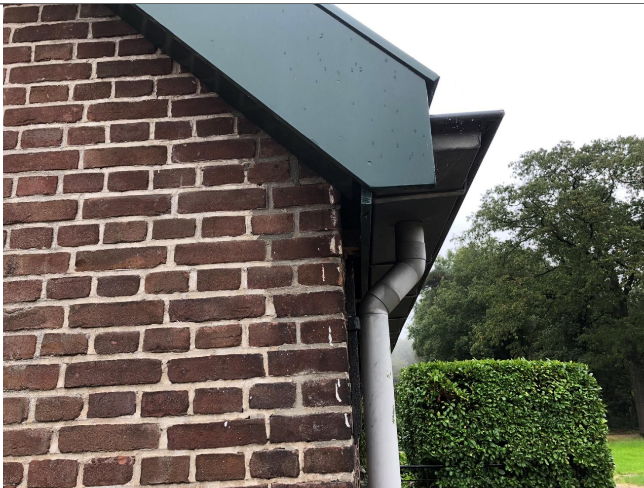
Achtergevel – aansluiting windveer / goot
