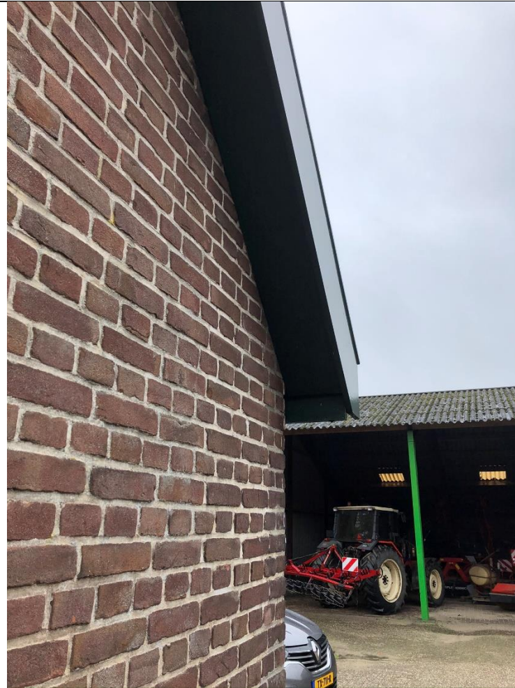
Achtergevel – kopgevel overstek
