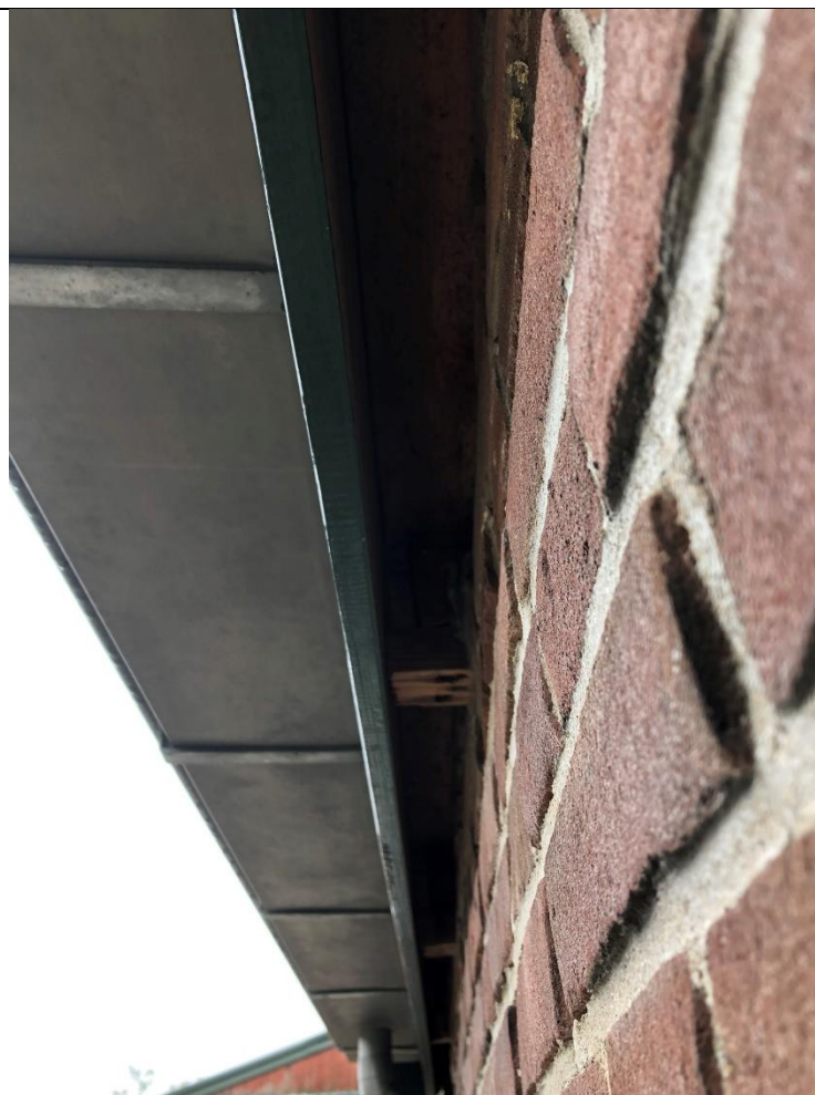
Linker zijgevel - gootplank
