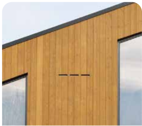
Vleermuiskasten achter gevelwerk
