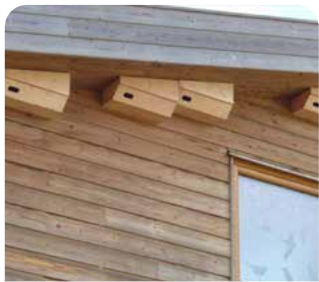
Losse of ingebouwde kasten
