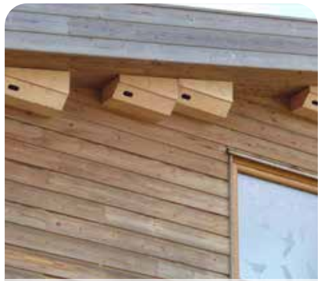
Losse of ingebouwde kasten
