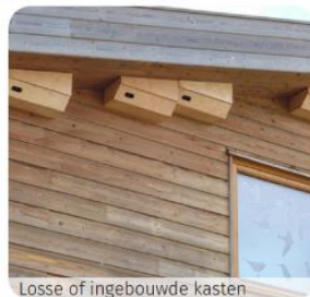
Losse of ingebouwde kasten
