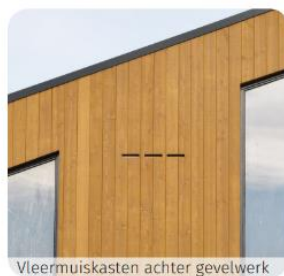
Vleermuiskasten achter gevelwerk
