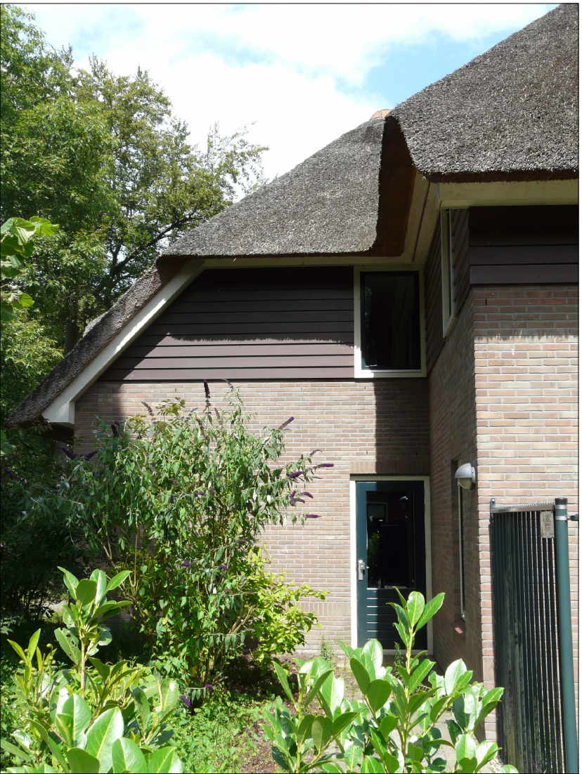
Zuid-westgevel / hoek te plaatsen installatie
