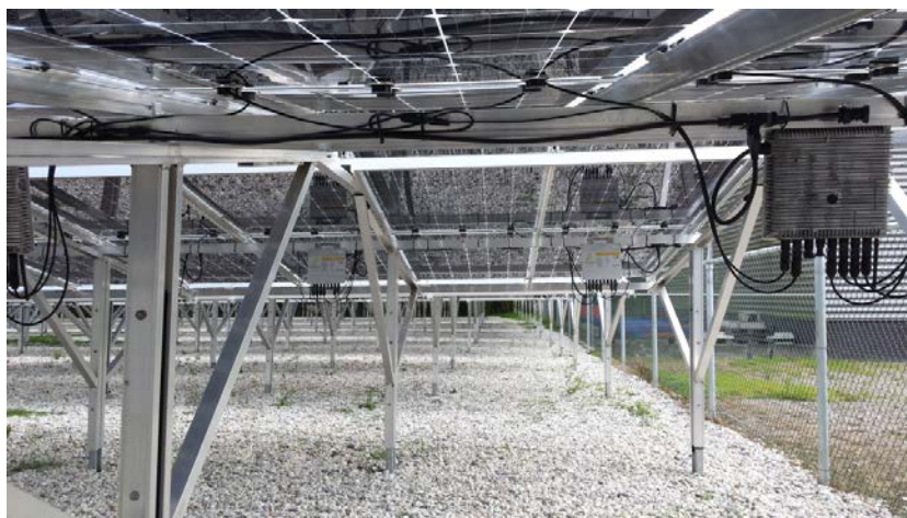
Figuur 13. Een zonnepark met micro-omvormers
