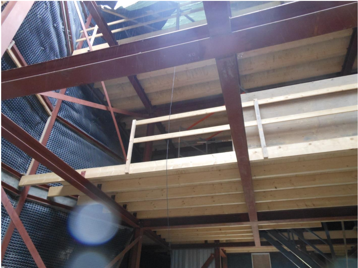
Houten vloer 1 e verdieping
